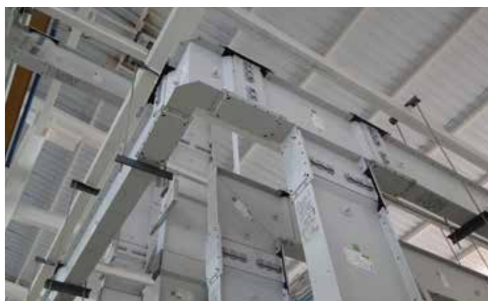
Система шинопроводов серии Zucchini
