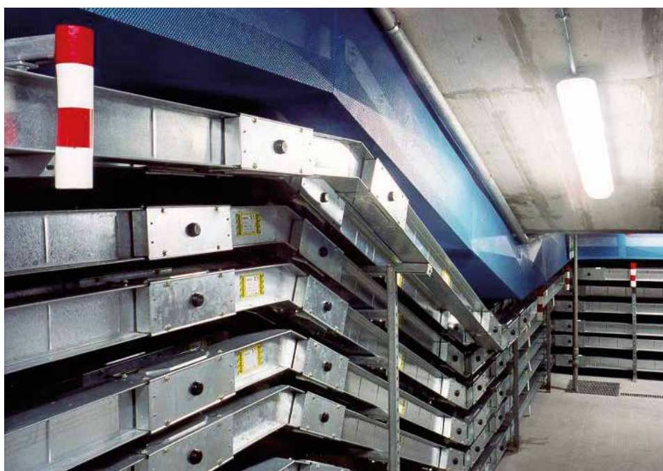
Шинопроводы для распределения электроэнергии высокой мощности
