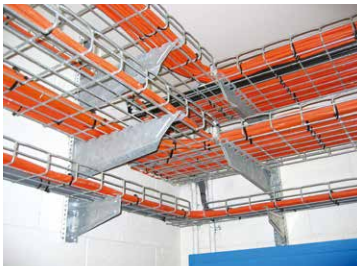
Система с кабельными лотками
