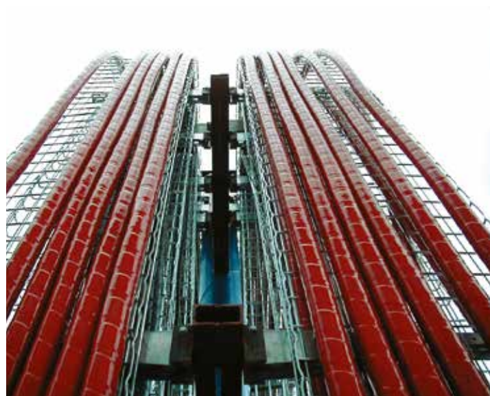
Система с кабельными лотками занимает больше места
